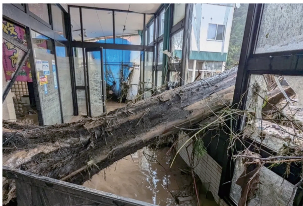
水害により丸太がガラスを突き破る(もとやスーパー店内)
