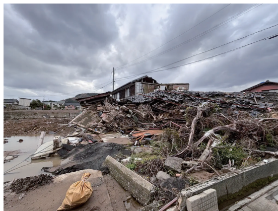
スーパー裏の家屋倒壊
